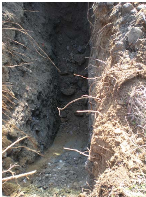
FIGURA 1.1 E FIGURA 1-2 ESECUZIONE SCAVI NELL'AREA DI INTERESSE
